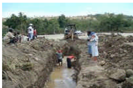
Foto de las obras en Arregy
